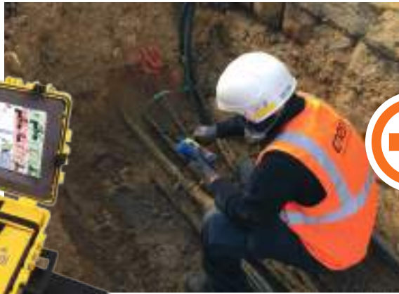
IDENTIFICATION DU BON CÂBLE DANS LA FOUILLE
